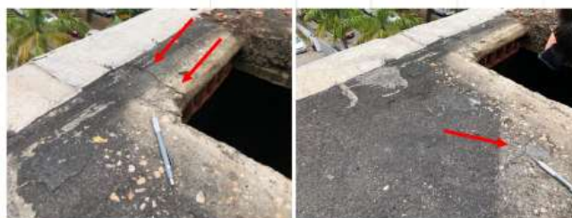
Fotografias 12 e 13 - Vistas da laje de tampa do reservatório. Observa-se fissuras de retração no concreto. Fonte – Próprio autor.
