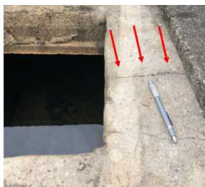
Fotografia 11 – Observa-se fissuras no concreto da laje de tampa do reservatório. Fonte – Próprio autor.
